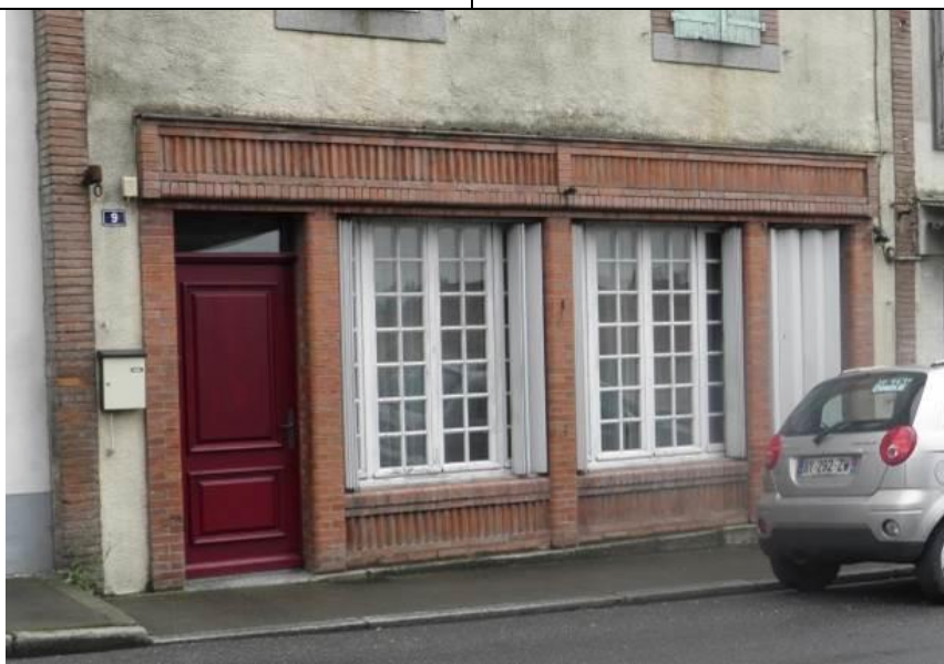
Exemples de RdC commerçants en brique situés dans les faubourgs, à conserver.
