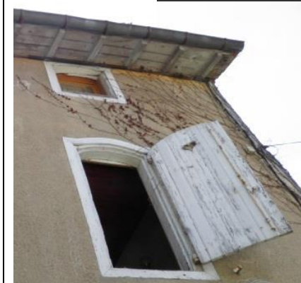
Exemple de référence de menuiserie à cadre en bois : le contrevent est fixé sur la feuillure.
